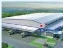
フクシマ工業 様 (24,000㎡) 冷機生産工場
