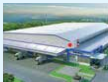
フクシマ工業 様 (24,000㎡) 冷機生産工場
