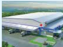
フクシマ工業 様 (24,000㎡) 冷機生産工場
