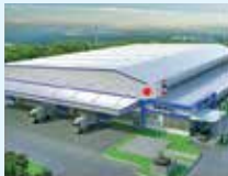
フクシマ工業 様 (24,000㎡) 冷機生産工場
