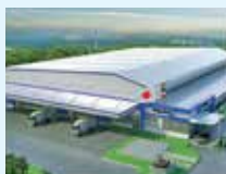
フクシマ工業 様 (24,000㎡) 冷機生産工場
