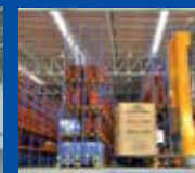
危険物を保管可能な建物仕様の倉庫
