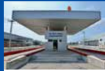
重量重量チェックゲート
