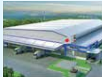
フクシマ工業 様 (24,000㎡) 冷機生産工場
