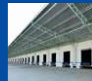
荷降ろし作業が容易なドックレベラー及びワンタッチオーバーシャッター設置
