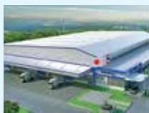
フクシマ工業 様 (24,000㎡) 冷機生産工場
